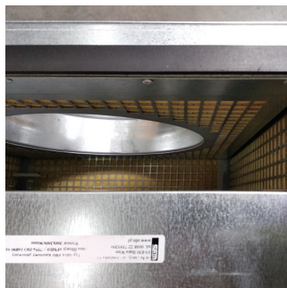
Izolacja akustyczna Wnętrze wyłożone 30 mm warstwą wełny szklanej.
