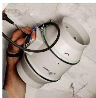
Przyłączenie przewodów zasilania
