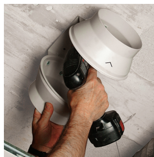
Przymocowanie wspornika
