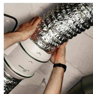
Montaż kanałów wentylacyjnych
